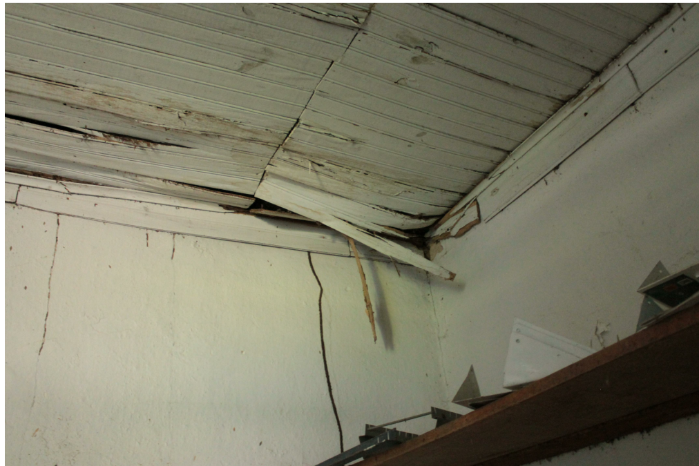
Forro em madeira da espécie lambri, instalado no depósito/porão bem desnivelado e apodrecido devido à umidade - Fazenda Boa Esperança. Cômodo localizado sob a sala 12. Foto: SECULT - Isabella Alves, 19/01/2022.
